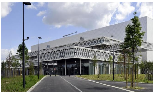
Les Archives Nationales à Pierrefitte-sur-Seine (93)
